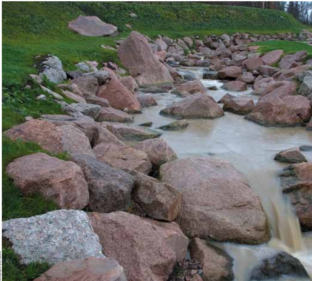
Genom att bygga laxtrappor kan man få vandringsfiskar att stiga uppströms förbi kraftverksdammar. Bilden är från
